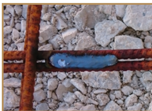
Cordon de soudure sur treillis
