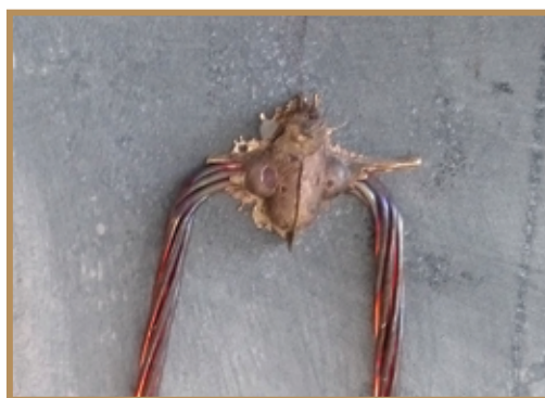
Détail de soudure par aluminothermie
