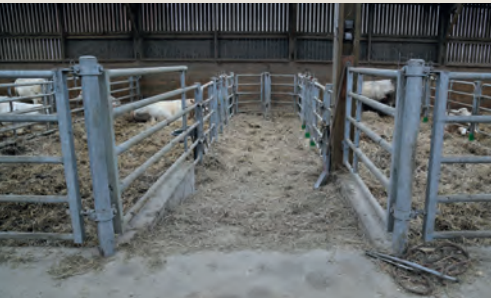
Un couloir transversal permet d'accéder facilement aux cases d'isolement et de tri
