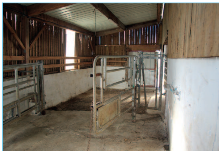
Au premier plan, l'infirmerie, avec sol bétonné, cornadis et barrière de protection latérale - A l'arrière-plan, la case d'isolement
