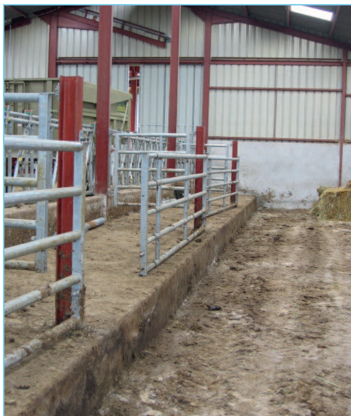
Après le curage de l'aire paillée, le détrempe et le décapage du bâtiment seront nécessaires pour éliminer toute trace de matière organique encore présente
