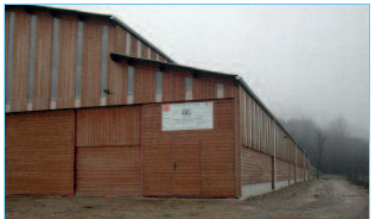
S'il est important, et selon l'exposition, le décalage de toiture peut être protégé d'un bardage largement ajouré
