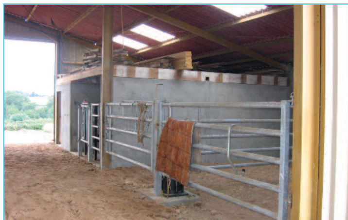
Aménagée dans un appentis donnant sur le couloir arrière, l'infirmérie est ici composée de 2 boxes et d'une zone d'intervention pour vêlages difficiles (derrière le mur)
