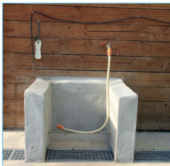
Lave bottes installé sous un auvent où l'éleveur et les intervenants garent leurs véhicules. L'accès au bâtiment se fait par un local technique dont la porte se situe juste à gauche du lave botte.
